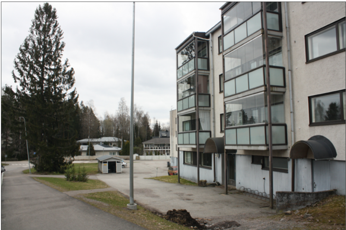
Näkymä Arolantien suuntaisesti, oikealla tontin 644-6 nykyisiä rakennuksia.
